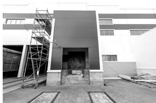
Строительство дополнительных тамбур-шлюзов на СГП ЦКК
