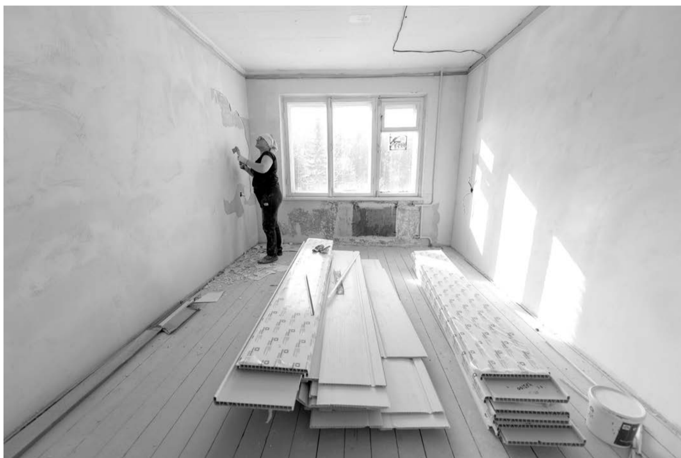
Ремонт помещений для гуманитарного центра
