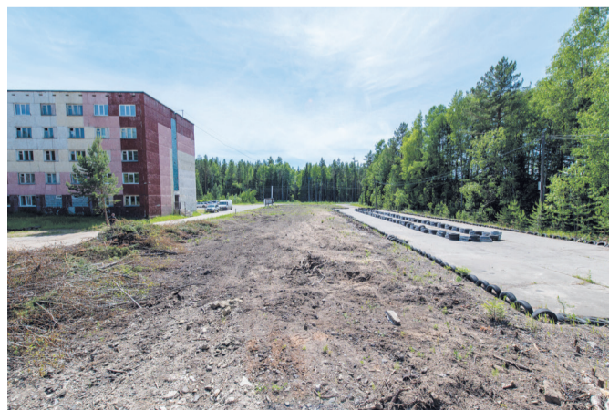
За зданием «Притяжения» началось благоустройство поля для мини-футбола. Площадка будет огорожена, освещена, с искусственным газоном и дренажом. Поле строится в рамках программы «Есть решение» «Единой России» при софинансировании компании Эн+. Срок окончания работ – середина августа.
